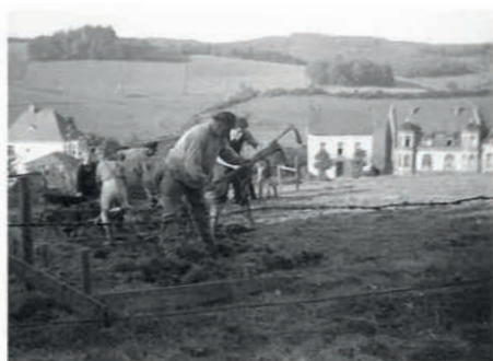
Beginn der Ausschachtungsarbeiten für die erste evangelische Kirche durch den MGV Oberbrügge unter dem Vorsitzenden Herrn Walter Piene am 27. Oktober 1951.
