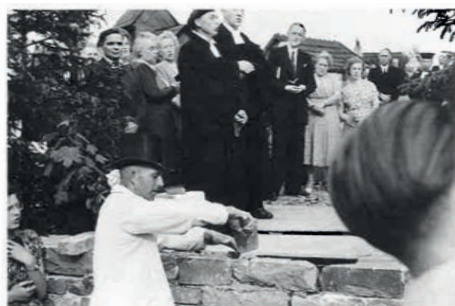
Grundsteinlegung zur ersten evangelischen Kirche am 29. Juni 1952. Einmauerung des Grundsteines durch Herrn Bauunternehmer Fritz Fastenrath. Im Vordergrund der Kirchenchor, im Hintergrund Herr Landeskirchenrat Nockemann und Herr Superintendent Köllner.
